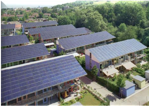
The Solar estate 'Solarsiedlung Freiburg am Schlierberg', Freiburg, Germany, source: Büro Disch.
