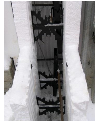
Coffrage à béton isolant (CBI)
