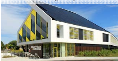
Bibliothèque de Varennes, Québec © Maxime Gagné, façade PVIB
