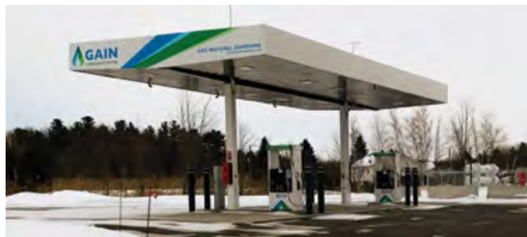
Poste de ravitaillement U.S. Gain à Lanoraie, Qc, pour Express Mondor, construit par ComTech Energy
