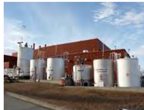
Installation d'essai du traitement de la mousse de bitume, RNCAN CanmetÉNERGIE, Devon (AB)
